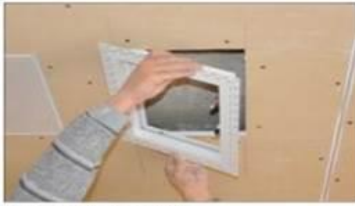
DIŞ ÇERÇEVE YERLEŞİMİ ASSEMBLY OF OUTER FRAME
